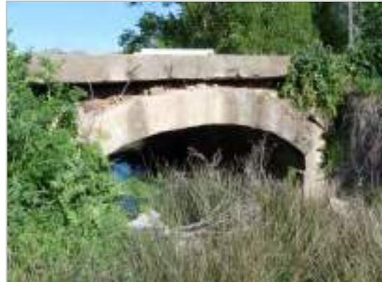
**Fig. 49.-** Puente de sillares de piedra y un arco en el camino de acceso a las casas de La Pedraza.
