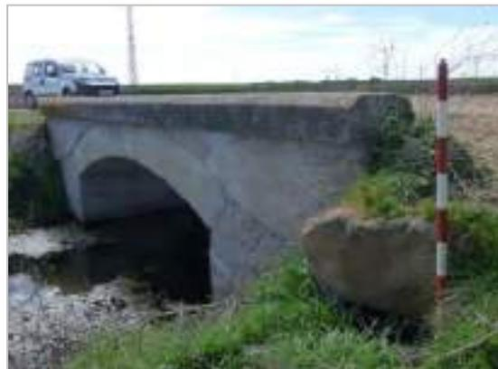
**Fig. 45.-** Puente del hormigón donde la zona Franco. Se observa un sillar de piedra que podría haber formado parte de un antiguo puente.
