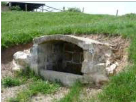
**Fig. 44.-** Fuente de La Antigua, con paredes de sillares de piedra y bóveda de cemento.
